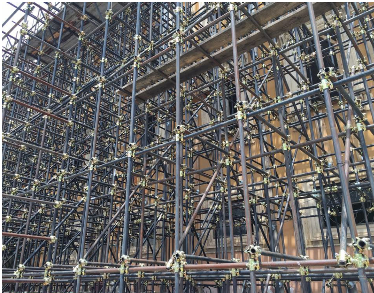
L'Aquila in ricostruzione ...
